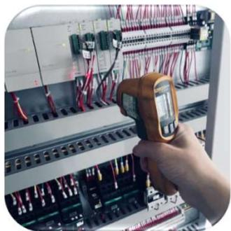
5、设备运行时，检测配电柜线路温度。
