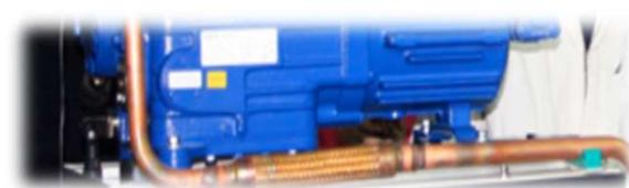
3、管道防护措施：制冷系统管路采用增加防振软管和 C 型弯头的方式避免因振动和温度的变化引起的铜管和破裂。
