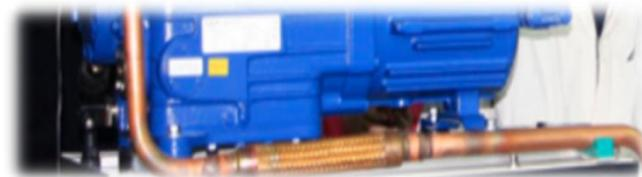
3、管道防护措施：制冷系统管路采用增加防振软管和 C 型弯头的方式避免因振动和温度的变化引起的铜管和破裂。
