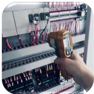
5、设备运行时，检测配电柜节点温度。
